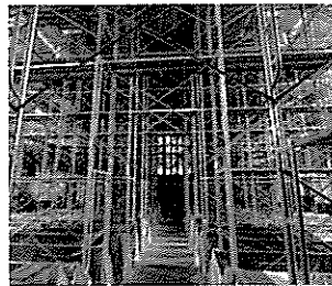
礼拝堂復旧工事の様子
